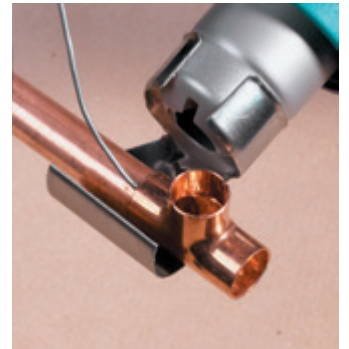
Lemljenje bakrenih cijevi
